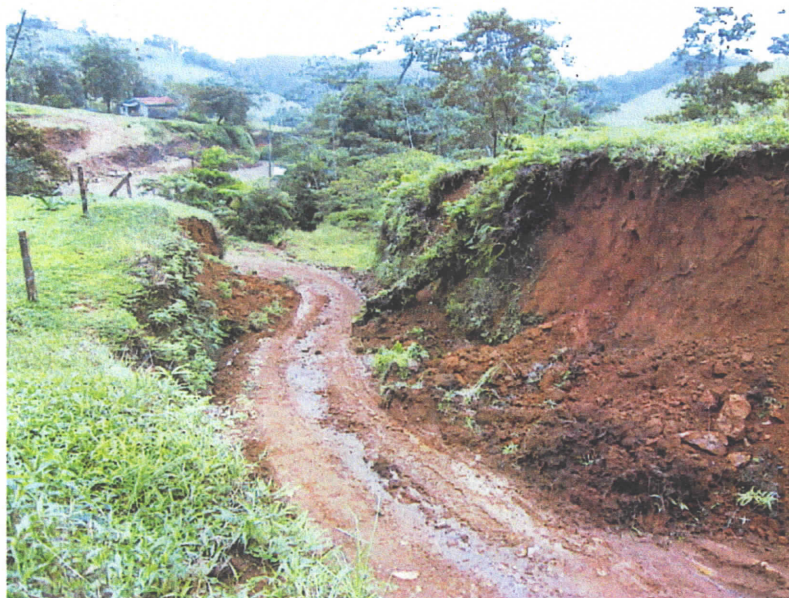
Fotografía 2. Deslizamiento a lo largo de un camino en El Pilón de Bijagua.
